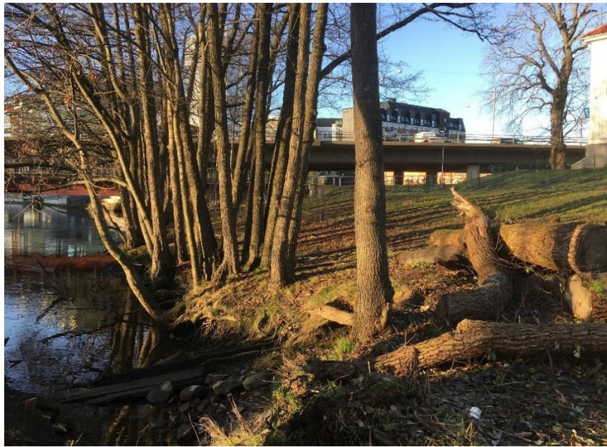
Figur 4. Pågående erosion vid ca sektion 130N. (2021-12-20)
